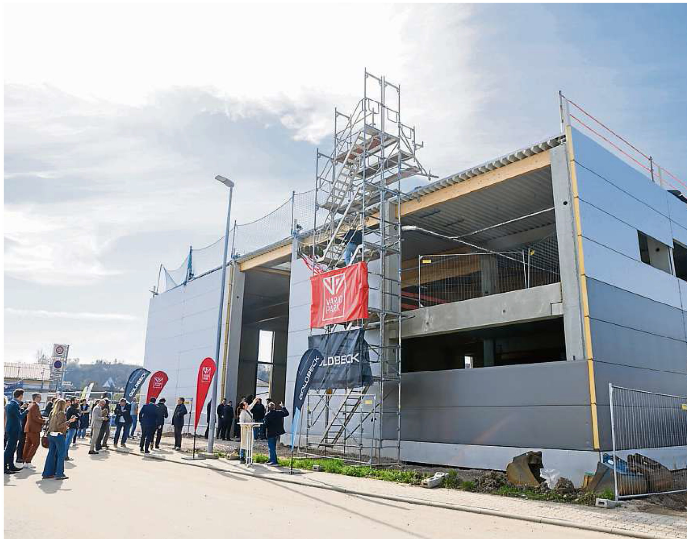
Richtfest für den „VarioPark“: In Nackenheim entsteht ein sogenannter Gewerbepark.
